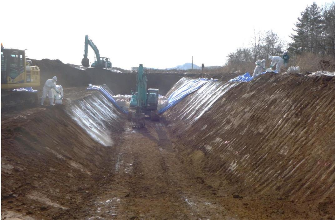
埋却溝の掘削及び石灰散布
